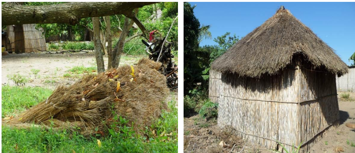
Fig. 18 - Palha para cobertura de casas (à esquerda) e casa típica (à direita)
